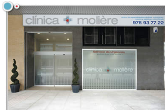
Ilustración 2 Fachada de la clínica.
